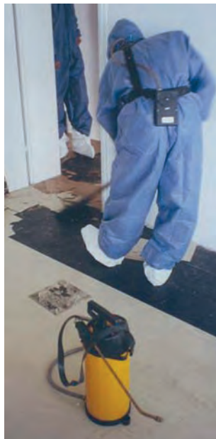
Abb. 1: Ausbau asbesthaltiger Fußbodenbeläge (Flexplatten)
