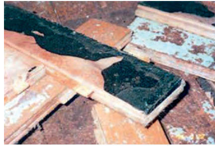
Abb. 7a, b: Sanierung PAK-haltiger Parkettkleber
