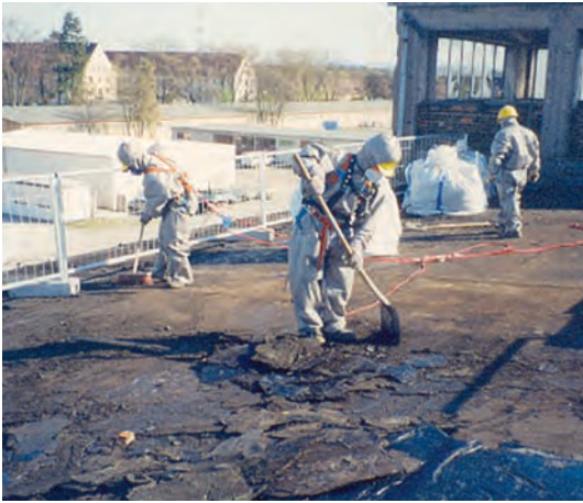
Abb. 6: Ausbau PAK-haltiger Dachbahnen
