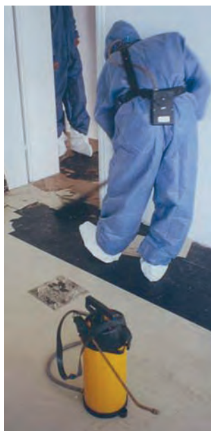
Abb. 1: Ausbau asbesthaltiger Fußboden- beläge (Flexplatten)
